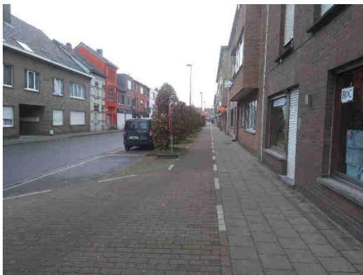
Asymmetrisch profiel (fietspad langs één zijde)
